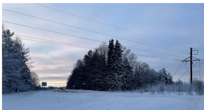
Рис. 4. Устранение провиса ВОЛС после очистки налипшего снега
