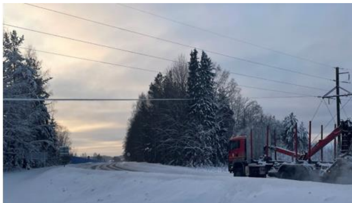
Рис. 3. Провис ВОЛС над автомобильной дорогой, мешающий проезду крупногабаритной техники
