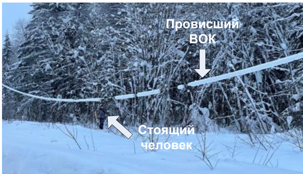
Рис. 1. Провис ВОК – изменение высоты подвеса в сравнении ростом человека
